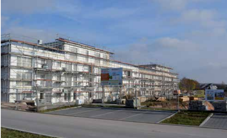
Baugebiet Dorotheenhöhe in Hilpoltstein: Die Erschließung des 2. Bauabschnitts beginnt.
