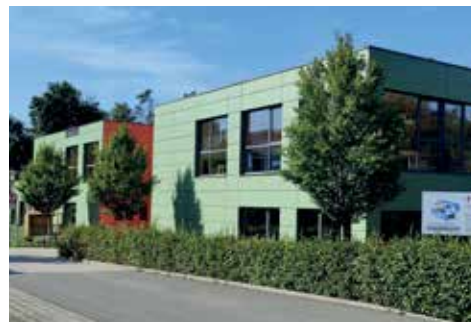
Die „Räuberkiste“ an der Mittelschule ist als Hort für bis zu 150 Kinder ausgelegt. Um den Raumbedarf für den Rechtsanspruch auf Ganztagesbetreuung ab 2026 zu decken, wurde eine Erweiterungs- und Umbaumaßnahme beschlossen.
